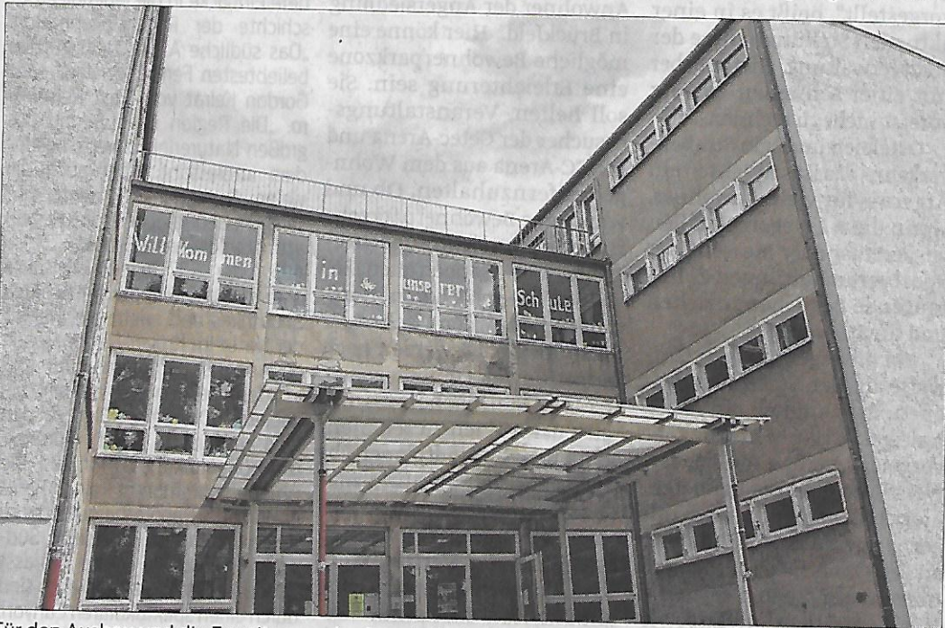
Für den Ausbau und die Erweiterung der Grundschule Diesdorf gibt es knapp eine Million Euro Fördergeld aus dem Programm Stark III.
